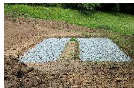
Photo 3 Bassin d'infiltration des eaux épurées.
