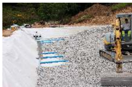
Photo 1- Fond de l'étage supérieur de traitement en construction. Mise en place des drains de récupération et du lit de granulats grossiers, support des bactéries.
