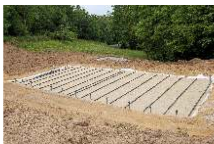
Photo 2- Sommet de l'étage inférieur de traitement en construction- Sable fin et rampes horizontales d'alimentation, prises d'air verticales.
