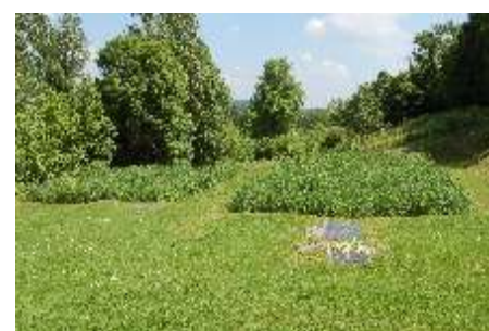
Photo 4 Filtres plantés de roseaux de la station de traitement de Chaillac (Haute-Vienne).
