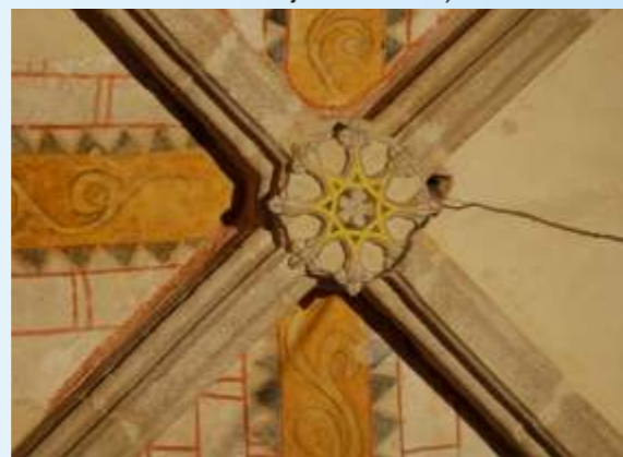
Le faux appareil (dessin de moellons avec double joint vertical)
