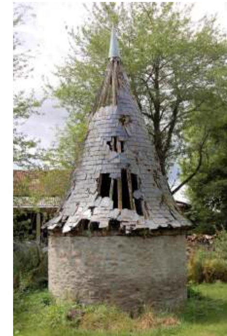
Le bâtiment dont la couverture va être réhabilitée
