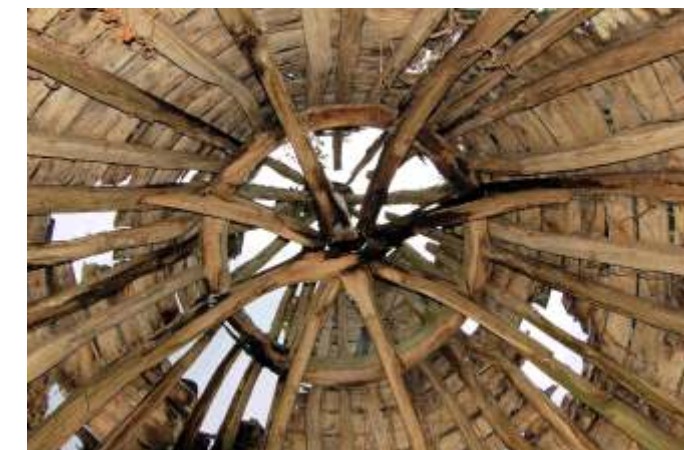
La charpente, remarquable.
