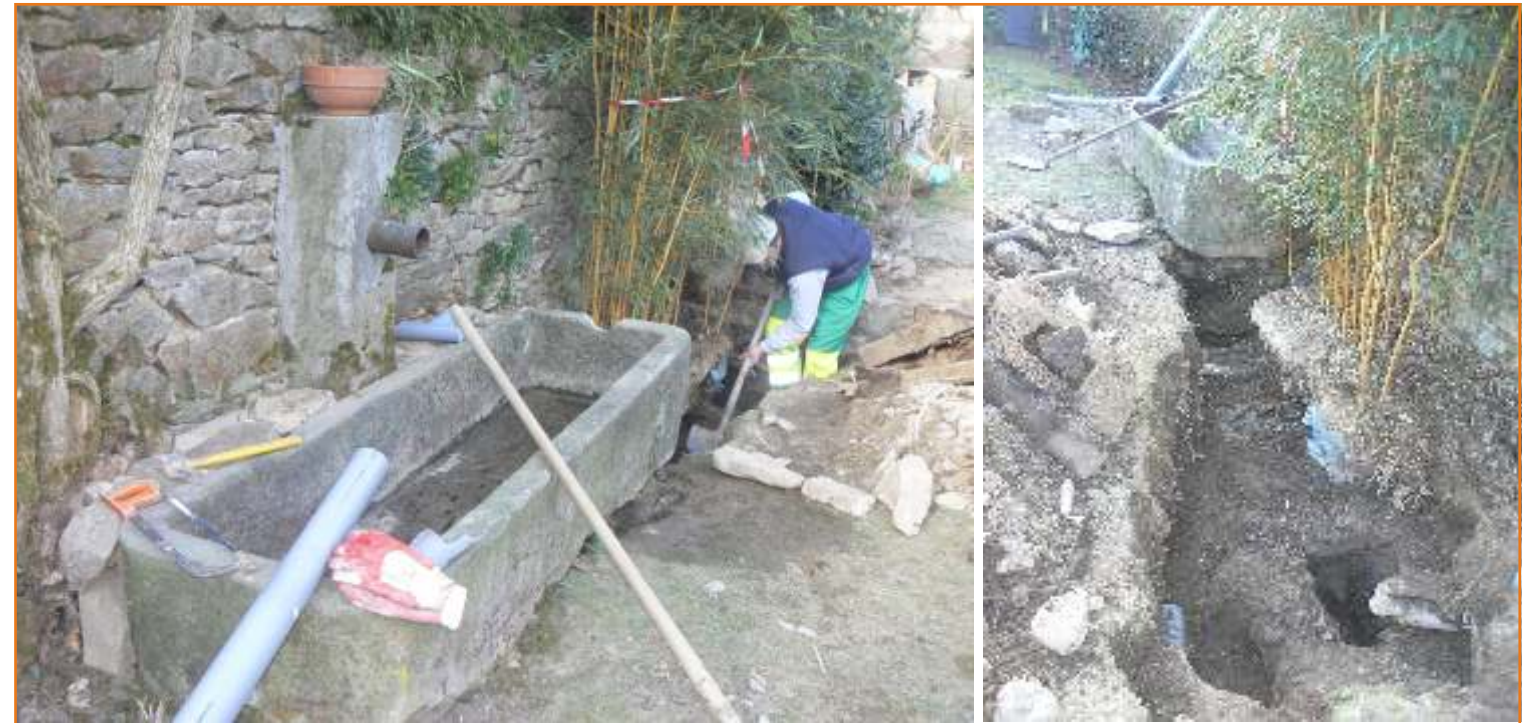
Travaux d'aménagement autour du répartiteur d'eau de Senon, réfection des canalisations d'alimentation des différents points de distribution.
