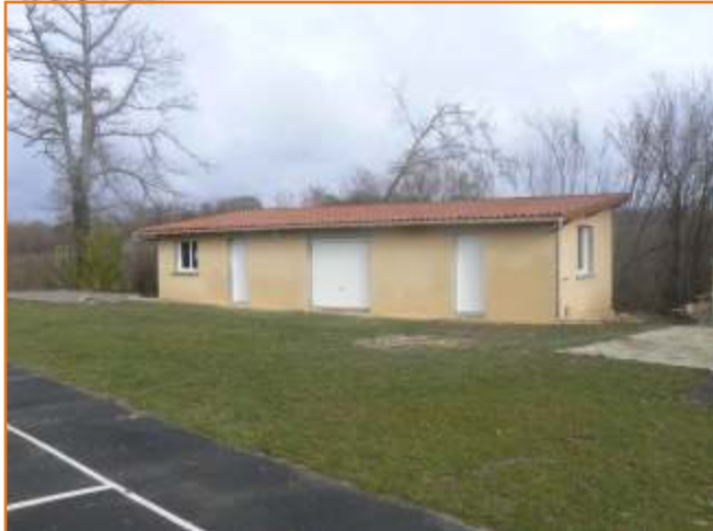
Réalisation d'un bâtiment de stockage et de rangement pour l'AS Saint-Gence et Saint-Gence Athlé.
