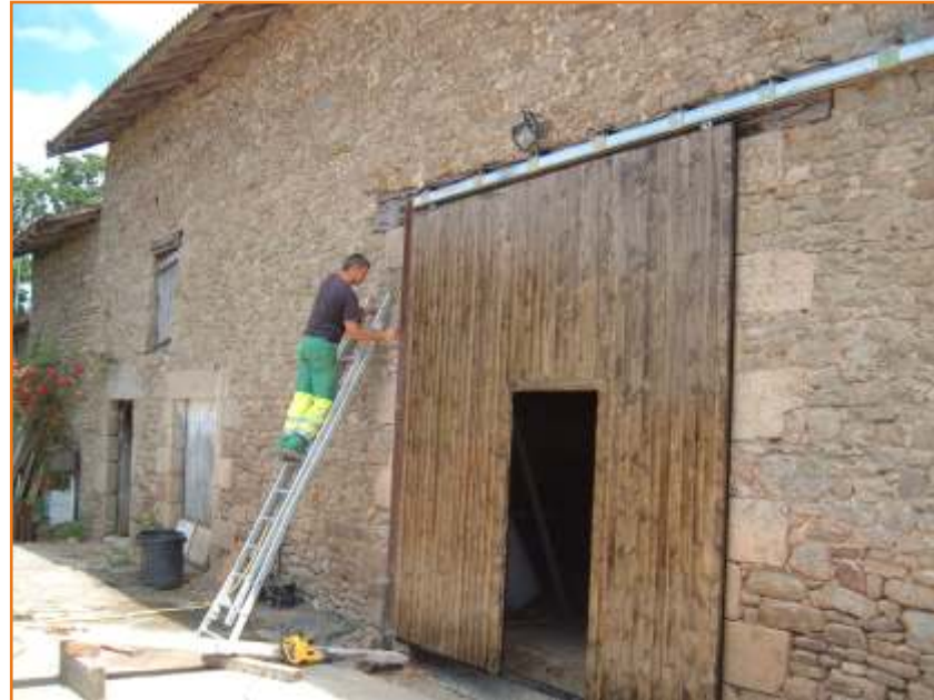
Fabrication et pose de nouveaux portails pour sécuriser les locaux techniques de la commune.
