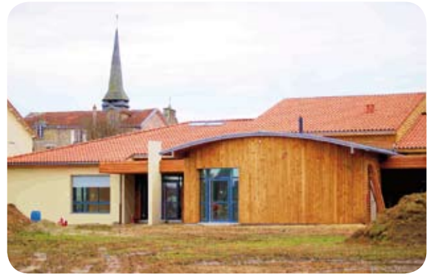
Façade avant en Co-vision de l'église - février 2010
