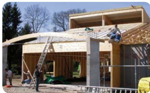
Corps central à ossature bois - 9 avril 2009
