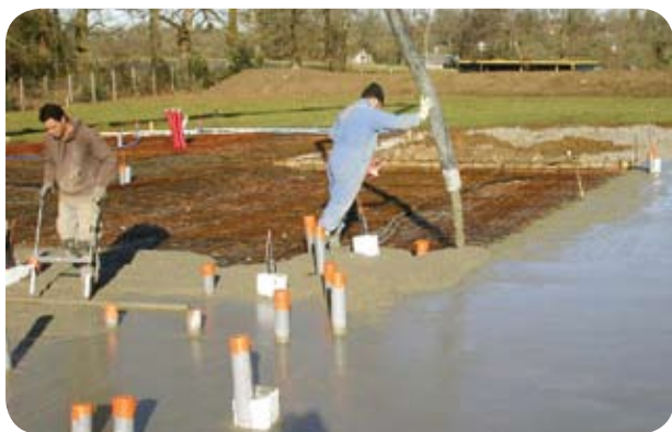
Coulage de la dalle - 30 janvier 2009
