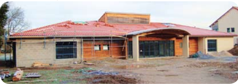
Façade arrière, côté Sud - décembre 2009
