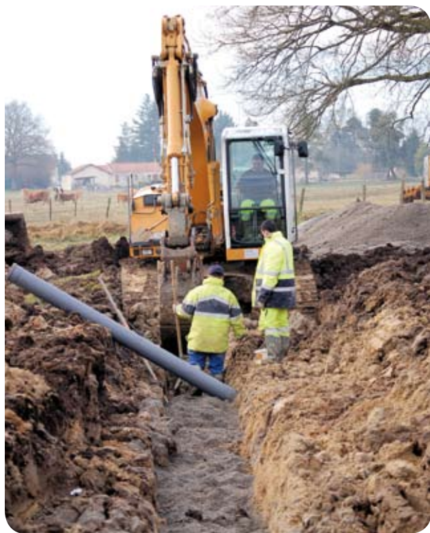
Réalisation des réseaux de collecte à La Châtre
