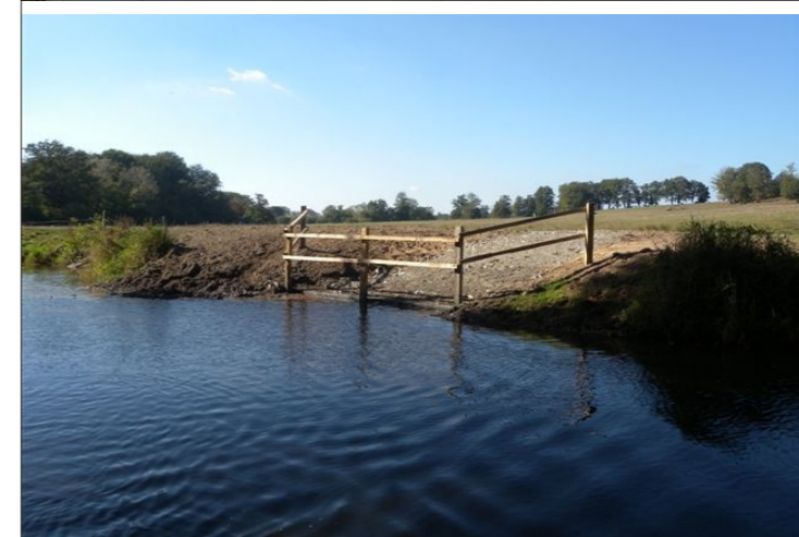
Réalisation d'un abreuvoir à bovins
