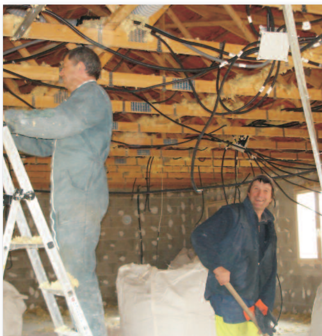
Travaux réalisés en régie (extension du multi accueil)
